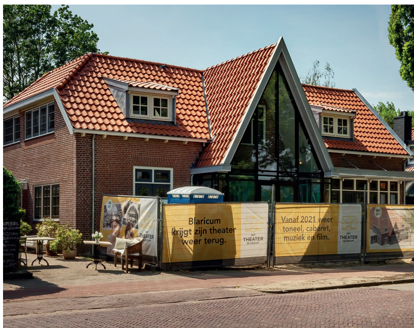
Binnenkort zullen de bouwhekken verdwijnen en zal Het Theater te bewonderen zijn.
