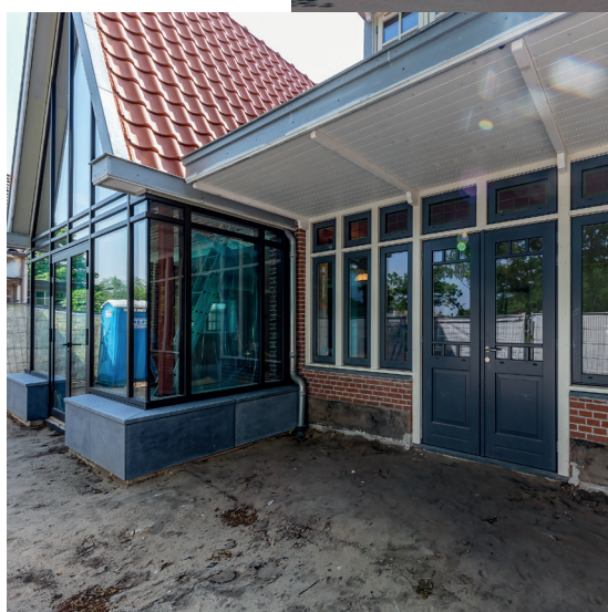
De hoofdingang en de deuren naar het terras kunnen bijna open.
